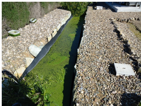
Foto 2. Canal de plantas flotantes: lemnas, Planta experimental Carrión de los Cespedes, grupo Tar 2012.
