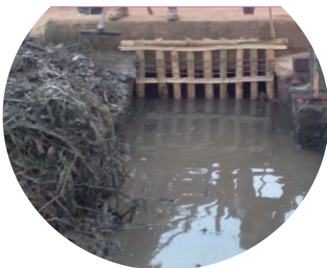
Fotos 4 y 5. Rejas de desbaste en Kimpese, R.D. de Congo, diseño grupo Tar, autoconstrucción comunitaria.
