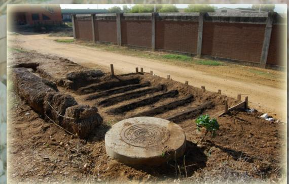
Reutilización de agua residual debidamente desinfectada en el Reactor Baccou, para generación de proteína vegetal alimentaria. Una vez usada, el agua doméstica, puede ser reutilizada en agricultura, con distintas exigencias de calidad según los usos. Además los fangos extraídos del agua residual debidamente tratados son un excelente compost. Plantación en talud estratificado en terrazas, con riego por gravedad. Plantas aromáticas, verduras, hortalizas y ornamentales.
