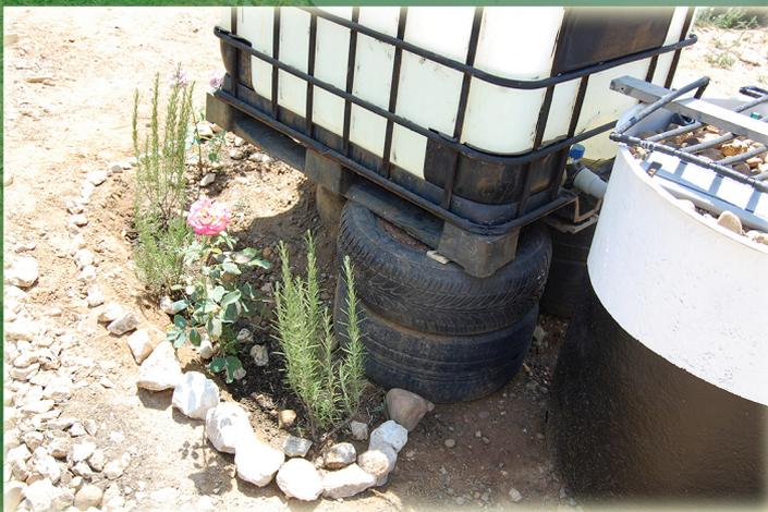
El sistema, compuesto por un tanque de alimentación y el reactor en sí, tiene como objetivo la puesta en contacto entre aguas residuales de tipo urbano con aire. Este contacto se realiza de forma natural al descender el agua entre el relleno del lecho, piedras angulosas, y ascender el aire desde el fondo por el citado lecho.
