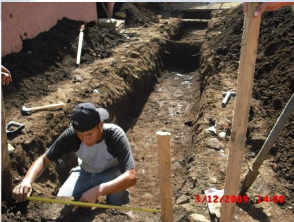
Construcción de zanja
