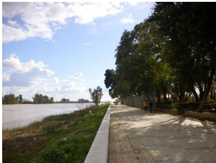
Figura 11: Estado actual del paseo fluvial de Coria del Río.
