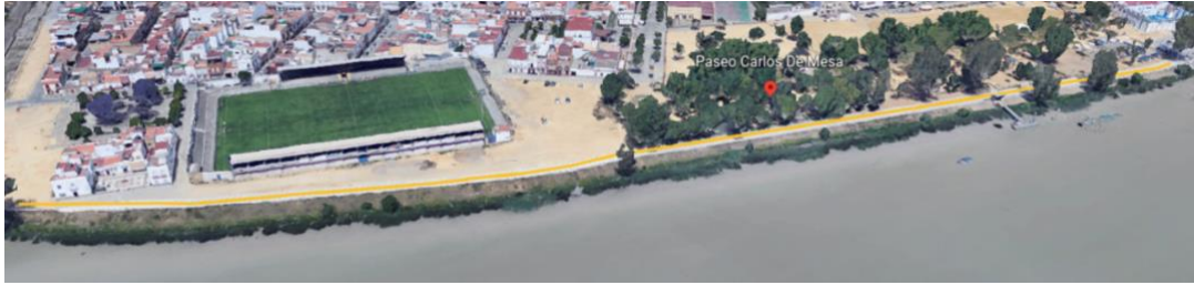
Figura 5: Tramo de actuación. Captura de Google Earth.
