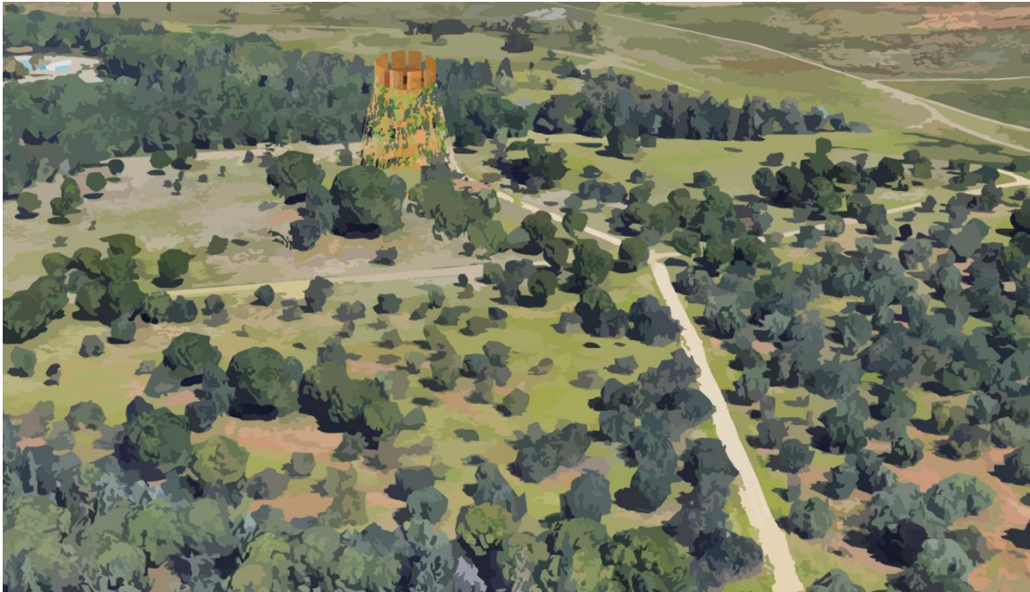
Figura 32: Integración de la torre en el entorno
