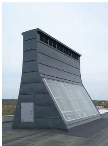
Figura 5.- Imagen de una chimenea solar.
