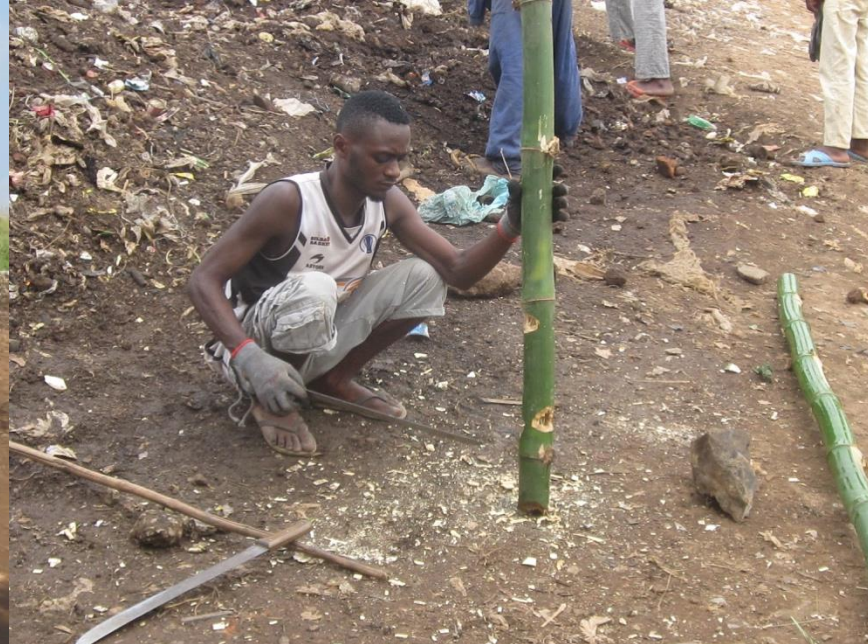
Construcción de tubos aireación
