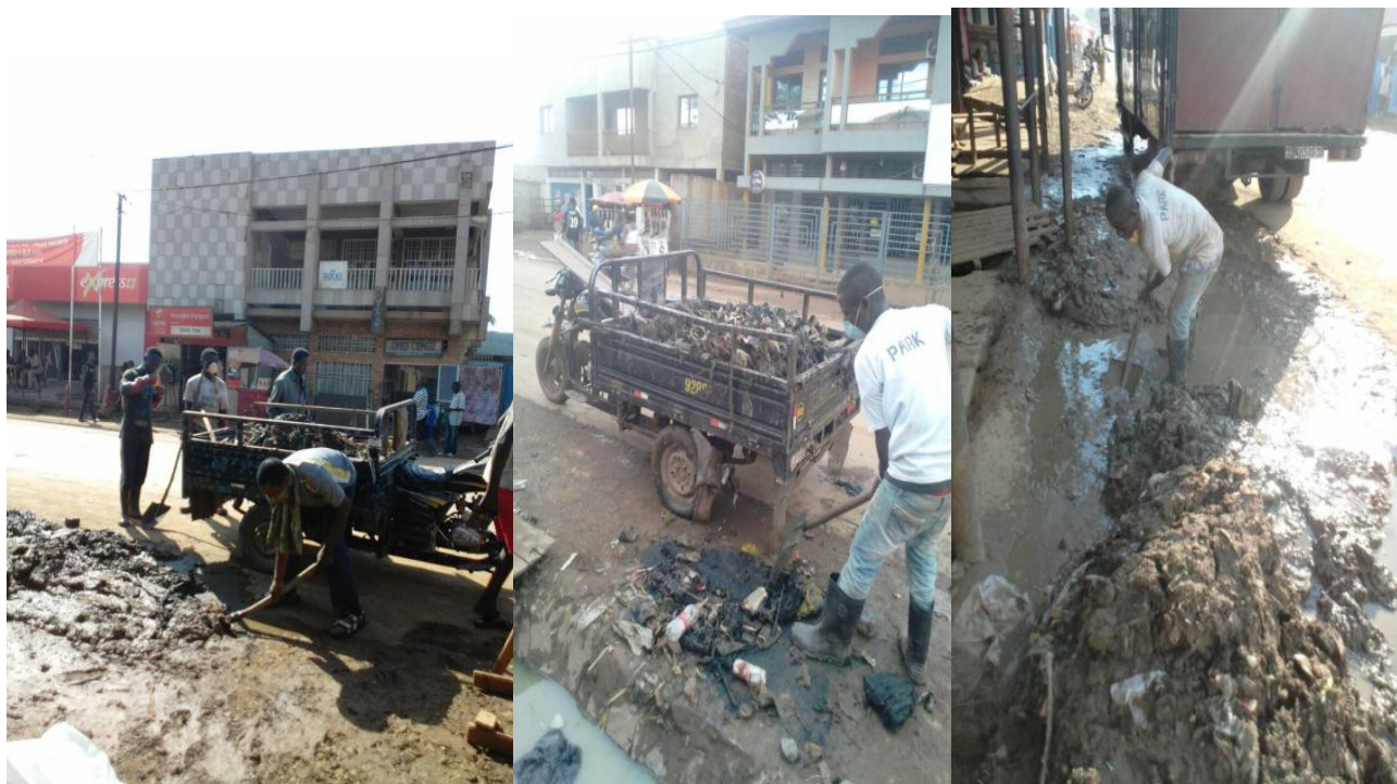
Limpieza de las cunetas de la Nacional 1
