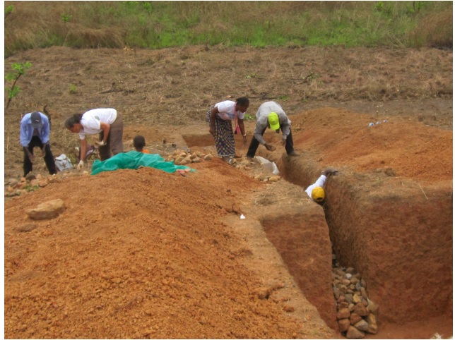
Colocación de las piedras en el canal de
