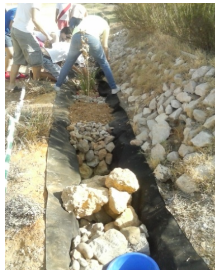
Canal de piedras
