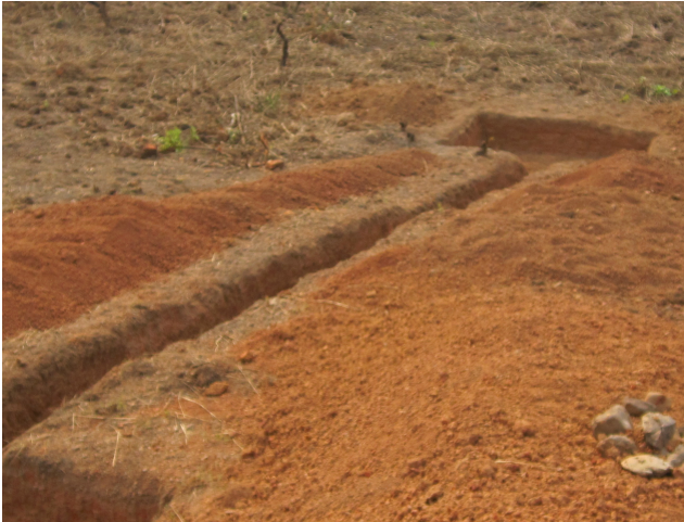
Excavación completa del canal y el estanque saneamiento
