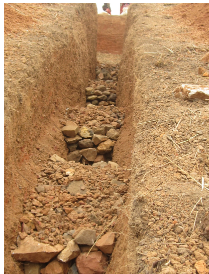
Detalle de la disposición de piedras por tramos
