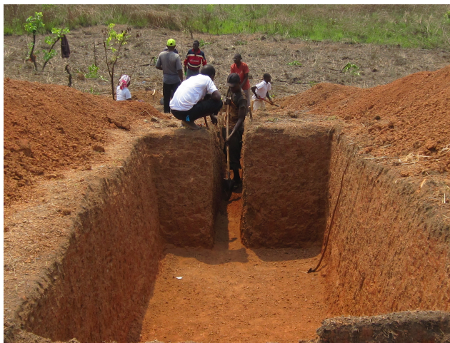
Excavación del canal de saneamiento
