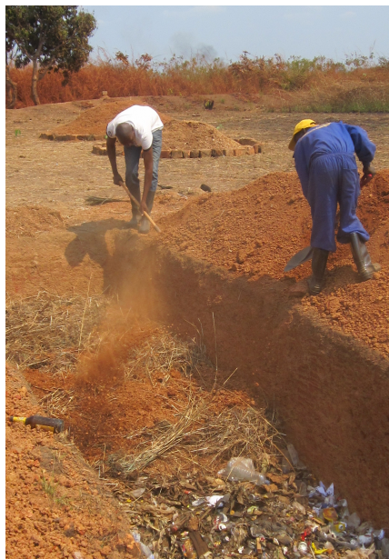
Capas de naturalización para intercalarlas entre los residuos
