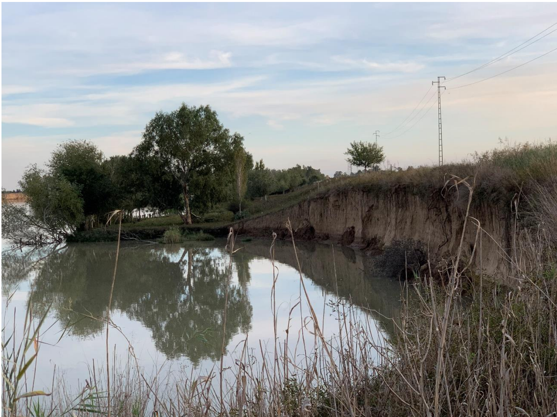
Figura 1. Fotografía derrumbe Puebla del Río. Fuente: Elaboración propia.
