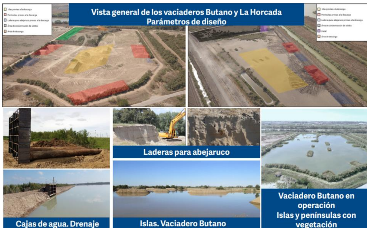
Ilustración 249. Secuencia de los trabajos realizados en los vaciaderos de Butano y La Horcada. Fuente: APS
