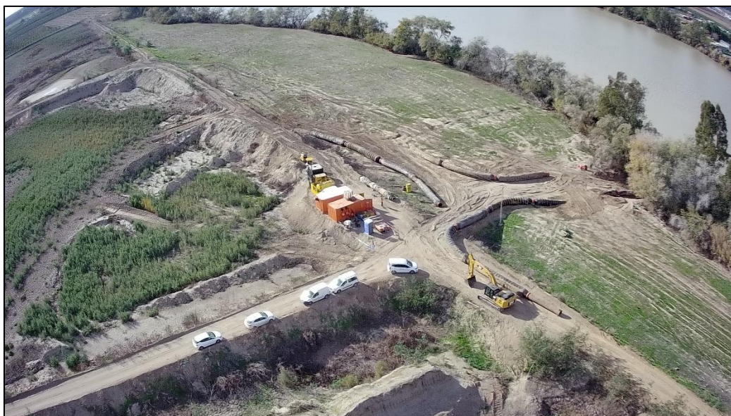
Ilustración 219. Acondicionamiento del vaciadero de Butano en una de las campañas de dragado de mantenimiento. Fuente: DRAVO, S.A., 2021.
