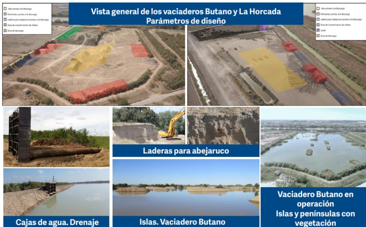
Ilustración 48. Secuencia de los trabajos realizados en los vaciaderos de Butano y La Horcada. Fuente: APS
