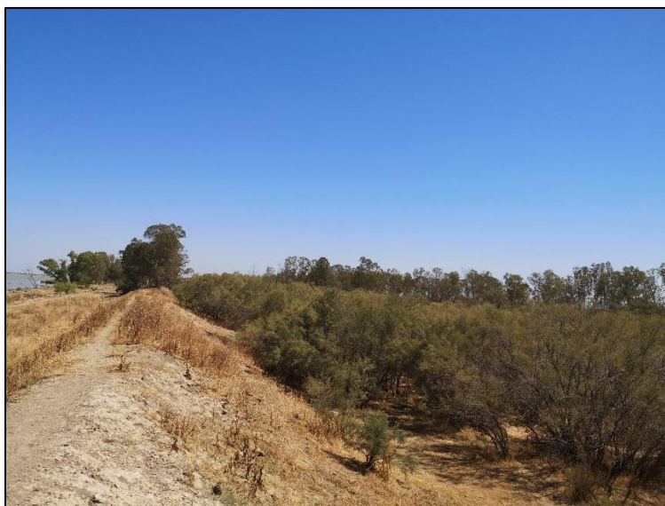
Ilustración 187. Estado actual de la mota del vaciadero La Mata. Fuente: propia, 2022.
