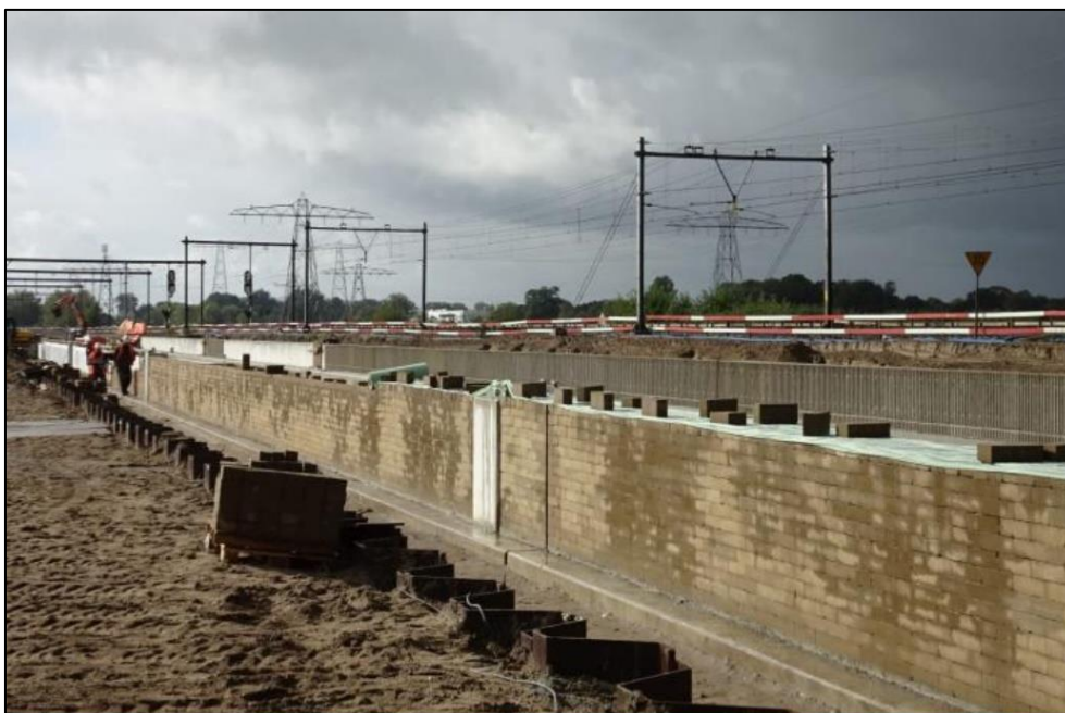
Ilustración 51. Ejemplo de una barrera acústica construida con sedimentos excavados en la construcción de un túnel de ferrocarril. Fuente: Geowall en Deltares, jornadas Sediment Management, 2021
