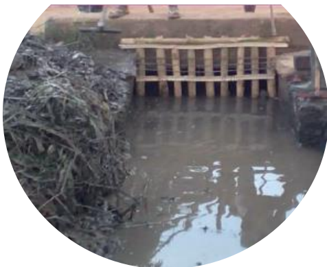
Ilustración 7. Rejas de desbaste en Kimpese, R.D. de Congo, diseño grupo Tar, autoconstrucción comunitaria.
