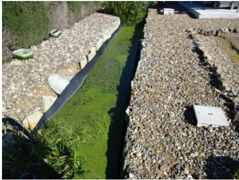
Ilustración 4. Canal de plantas flotantes: lemnas, Planta experimental Carrión de los Cespedes, grupo Tar 2012.
