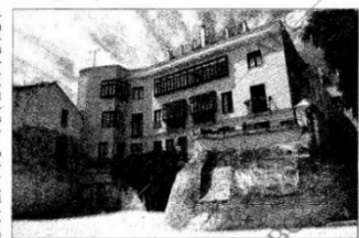
Otro de los restos de las Almonas, integrados en unas viviendas
