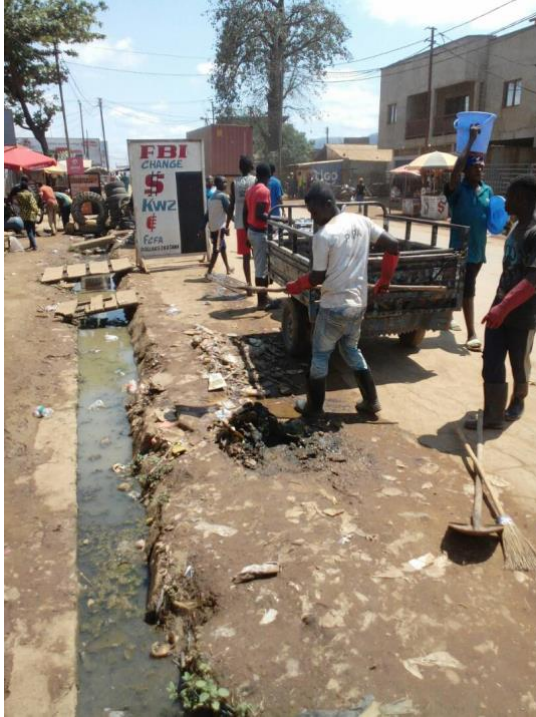
Foto 6: Canal desarenado en Kimpese, R. D. de Congo, grupo Tar.
