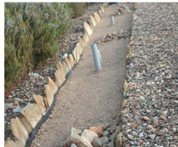
A la derecha, imágenes del canal de piedras construido en la Planta Experimental de Carrión de los Céspedes, Sevilla- España.
