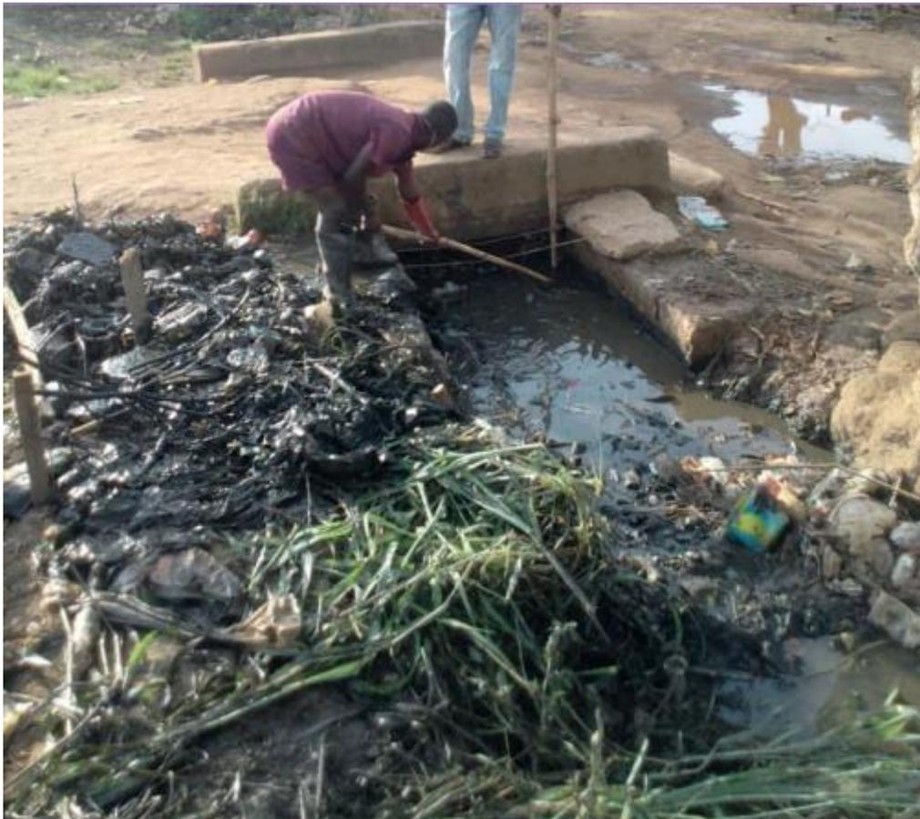
Isto pode ser solucionado, colocando uma grade para que os resíduos se concentrem num só sítio, fazendo assim com que seja mais fácil de apanhar e deixando dessa maneira que a água flua corretamente. Esta grade poder ser feita de tubos de bambú, sendo de fácil construção e tendo um impacto ambiental nulo.
