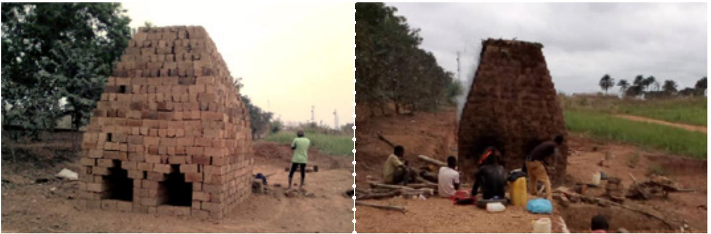
Figura 3.2.2. A la izquierda se está construyendo el horno y a la derecha se están cociendo los ladrillos.
