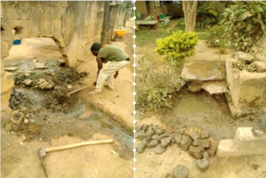
**Figura 5.3.8.** Preparación de la zona de acumulación y salida del agua de la parcela mediante la excavación de un canal. El canal se rellenó con piedras como trabajo complementario al del pozo de infiltración
