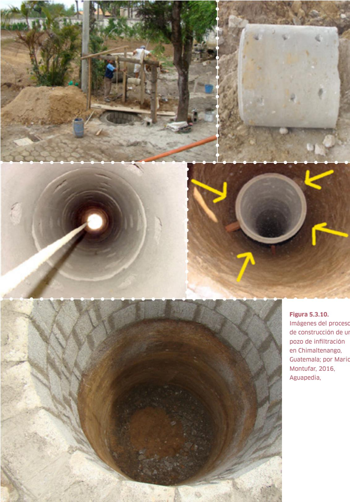
**Figura 5.3.10.** Imágenes del proceso de construcción de un pozo de infiltración en Chimaltenango, Guatemala; por Mario Montufar, 2016, Aguapedia,
