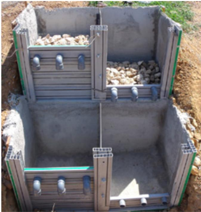
Figura 7.3.11. Prototipo de la escalera de oxigenación.
