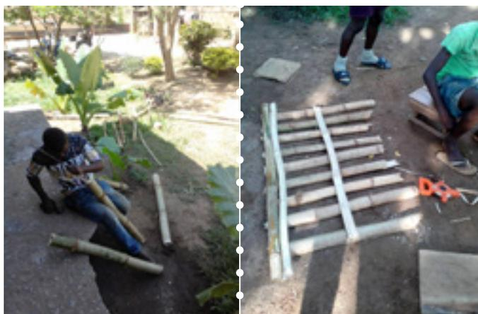
Figura 6.3.2. Construcción de las rejas para el saneamiento.
