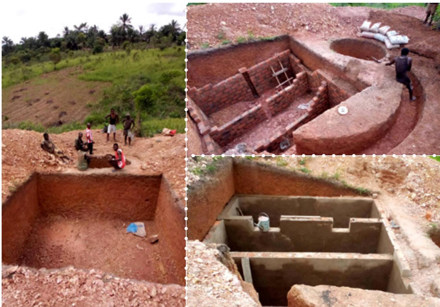
Figura 7.3.2. Fosa anaerobia piloto.
