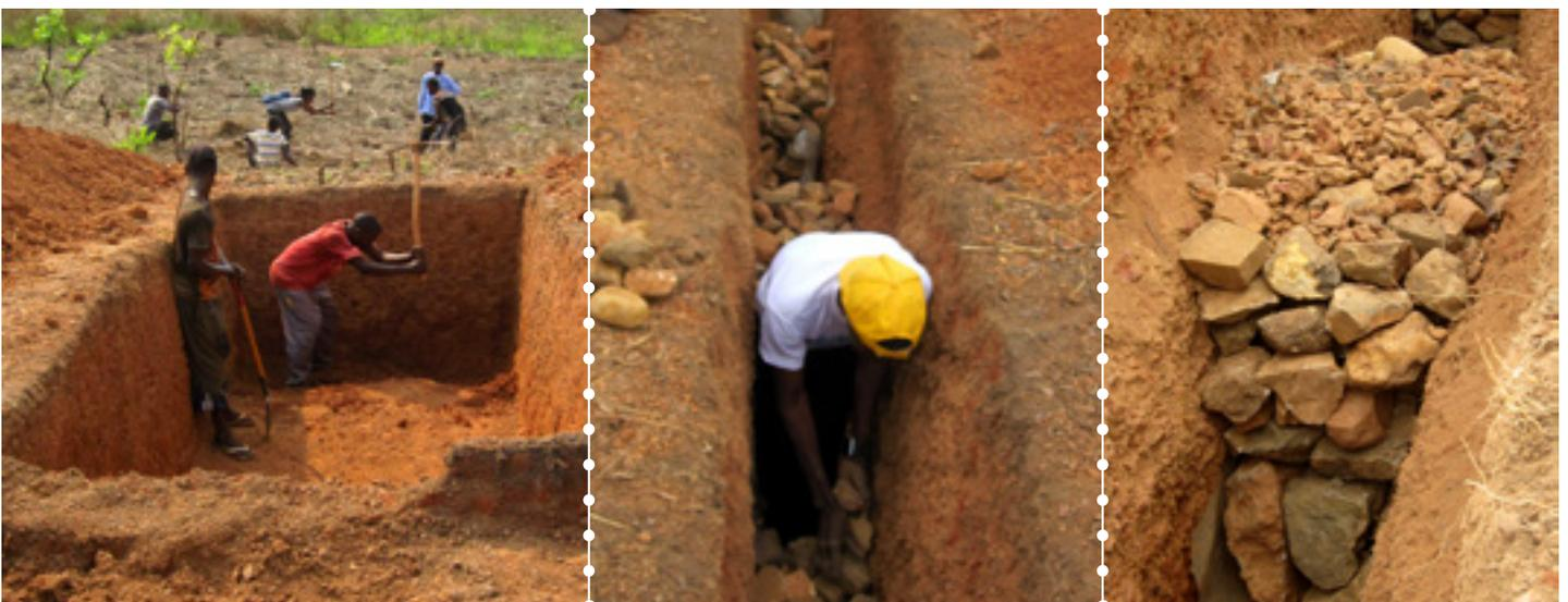
Figura 8.3.12. Excavación del vertedero y preparación del canal de piedras para la salida del lixiviado hasta su posterior saneamiento.
