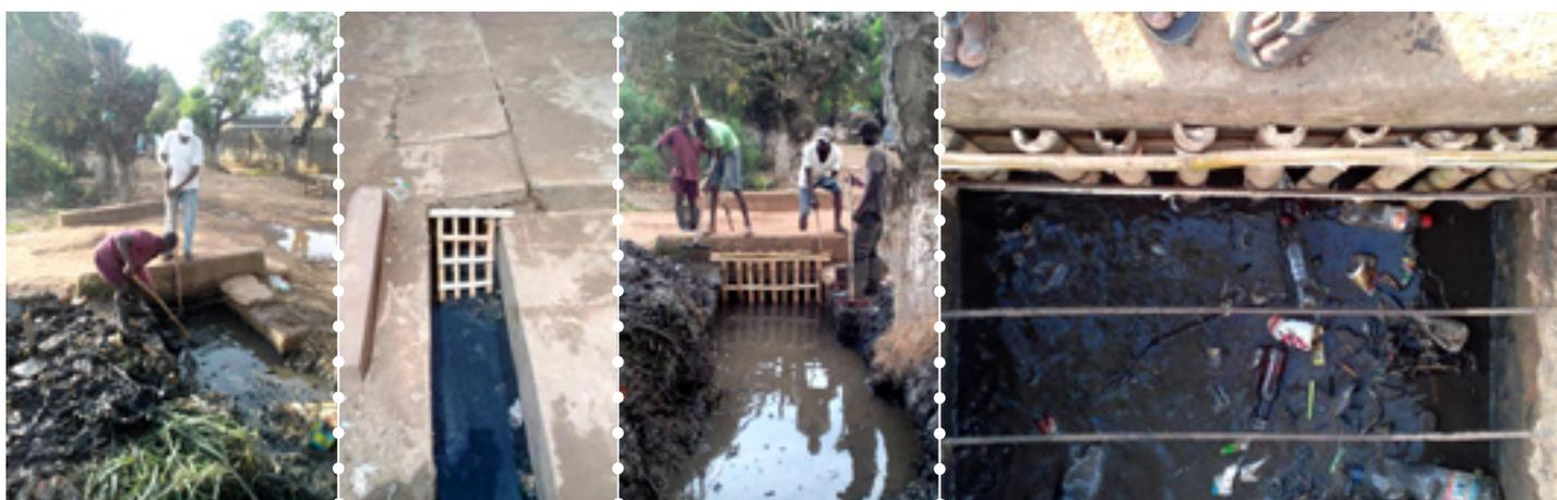
Figura 6.3.3. De izquierda a derecha: limpieza del canal, rejas colocadas y protección para solidos de gran tamaño delante de la reja vista desde arriba
