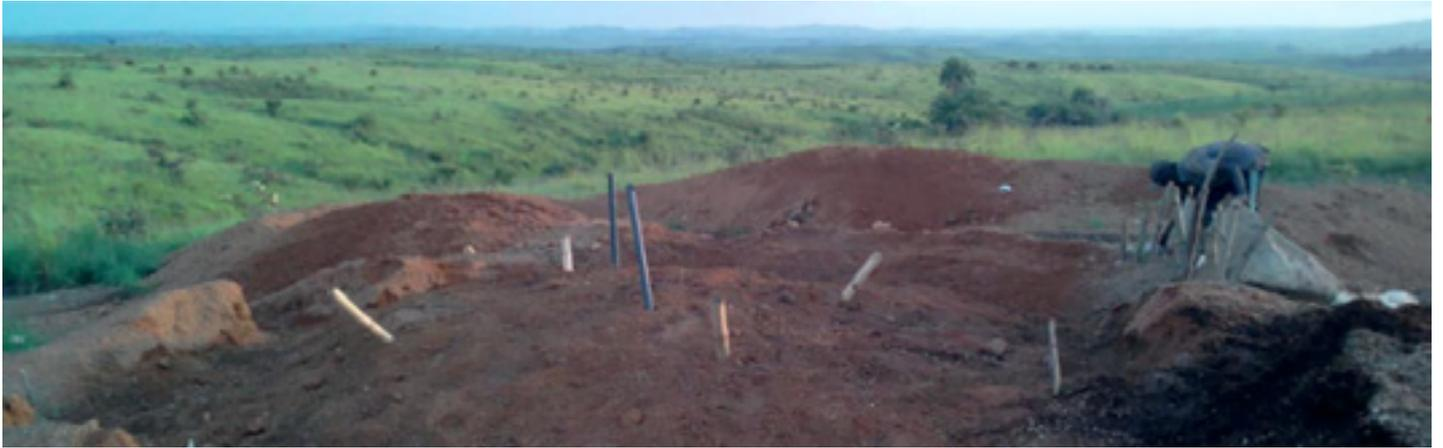
**Figura 8.3.14.** Vertedero sellado y con las chimeneas colocadas.
