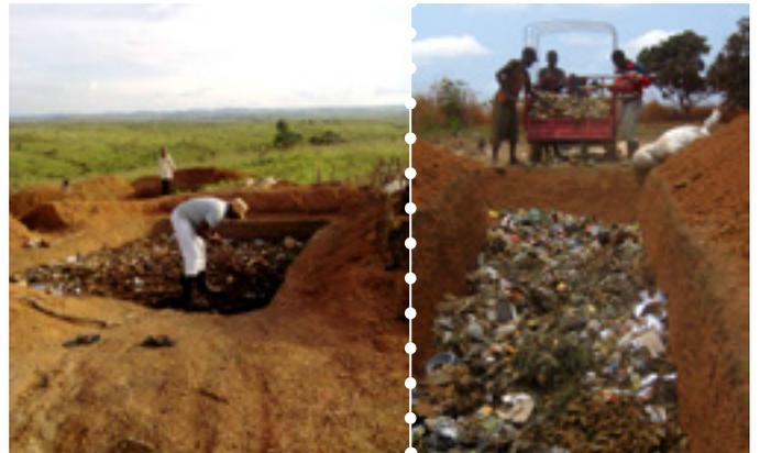
Figura 8.3.13. Relleno del vertedero por capas.
