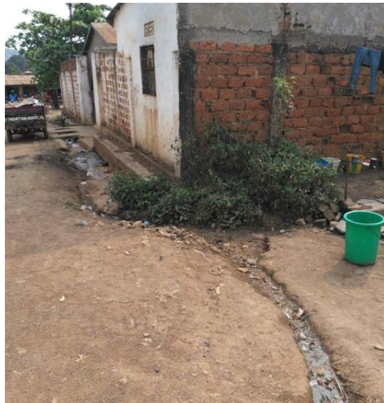
Algunos vecinos mejoran el canal en la zona de acceso a su vivienda cementando la zanja y colocando pasos de cemento. Obsérvese al fondo de la foto.
