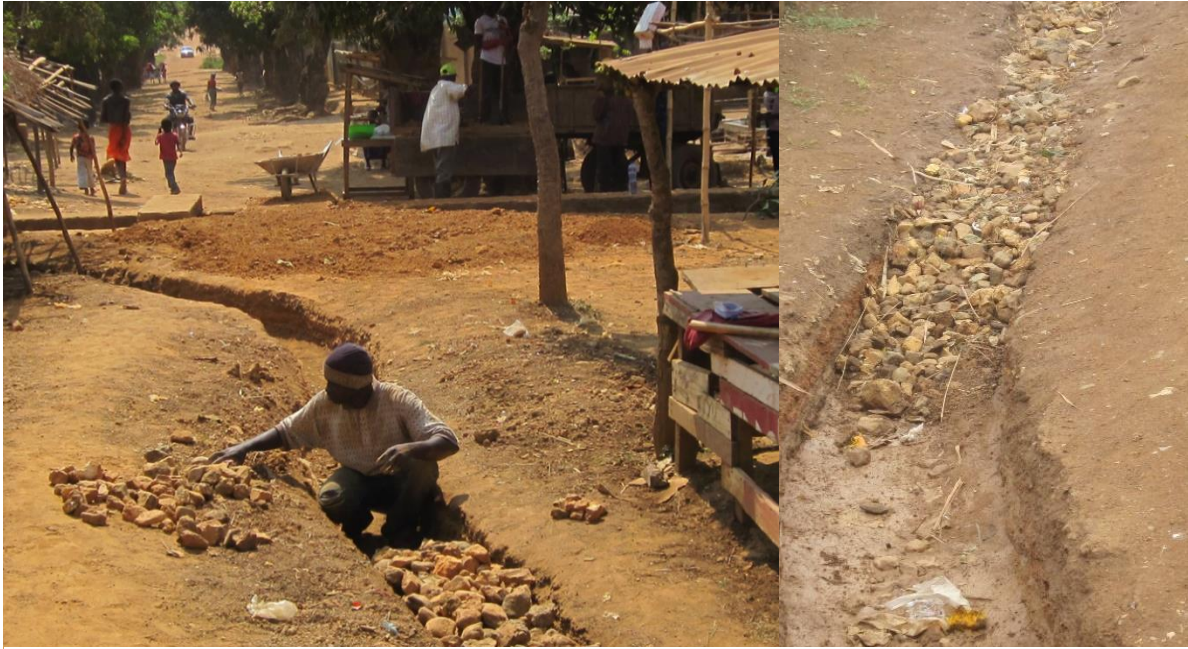
Relleno del canal con piedras.
