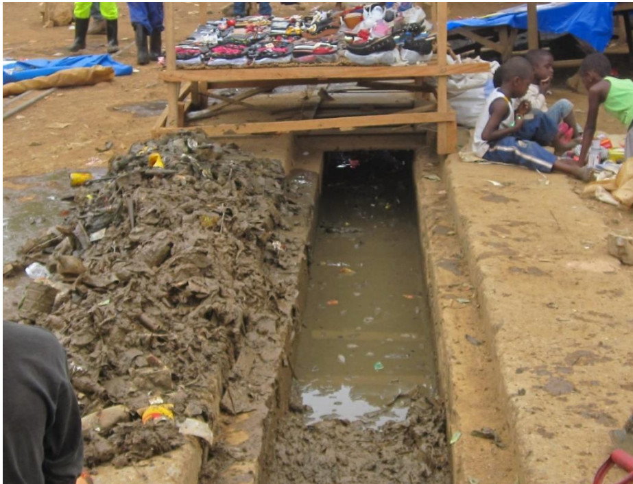
Avenida de comercio. Canal de desagüe construido por la administración pública provincial. En este momento los operarios han retirado la basura acumulada y los fangos formados.
