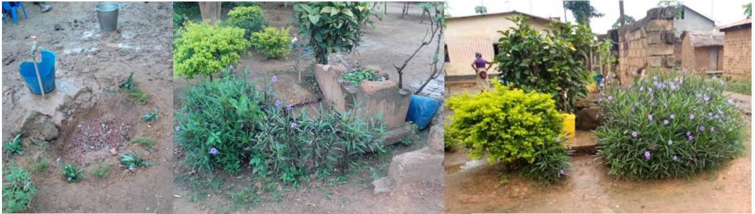
Pozo de infiltración con el paso del tiempo, con las plantas ya aclimatadas a las condiciones de humedad. De izquierda a derecha se observa el paso de los años, el problema del agua estancada ha desaparecido.
