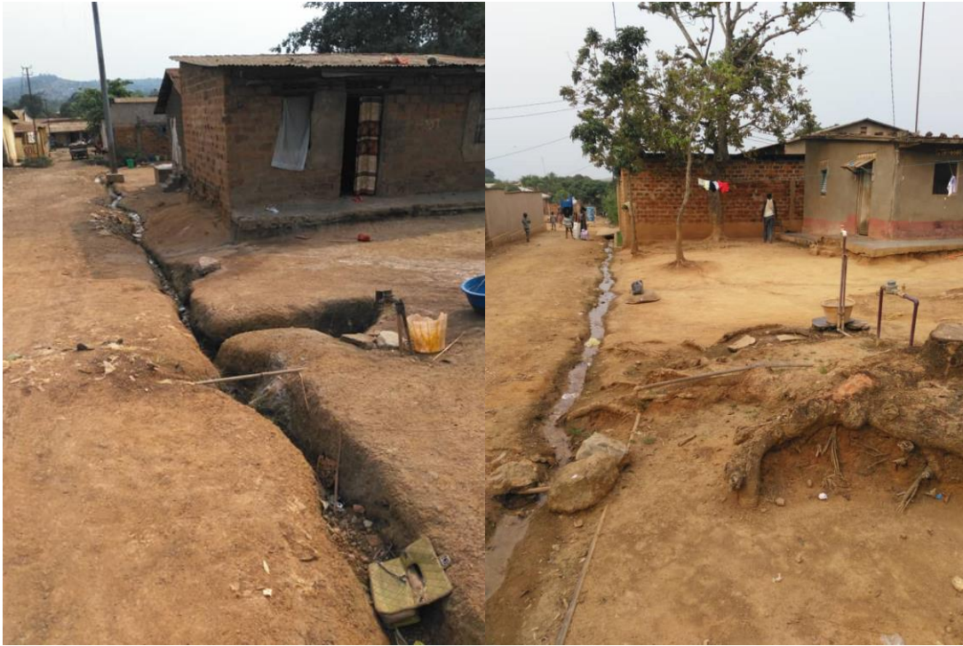
Canales de desagüe y evacuación de aguas domésticas contruidos por los vecinos. En este caso, cada vecino va acondicionando la zanja que evacúa su agua y a lo largo de la calle constituye dicho canal.
