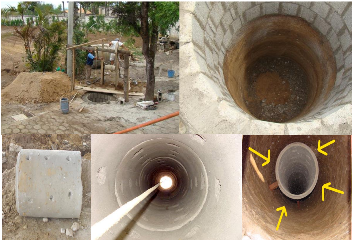
Imágenes del proceso de construcción de un pozo de infiltración en Chimaltenango, Guatemala; por Mario Montufar, 2016, Aguapedia,
