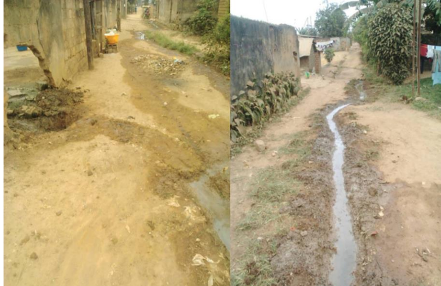
Aguas estacas en la avenida Sona Bata, procedentes del agua de lluvia y de uso doméstico.
