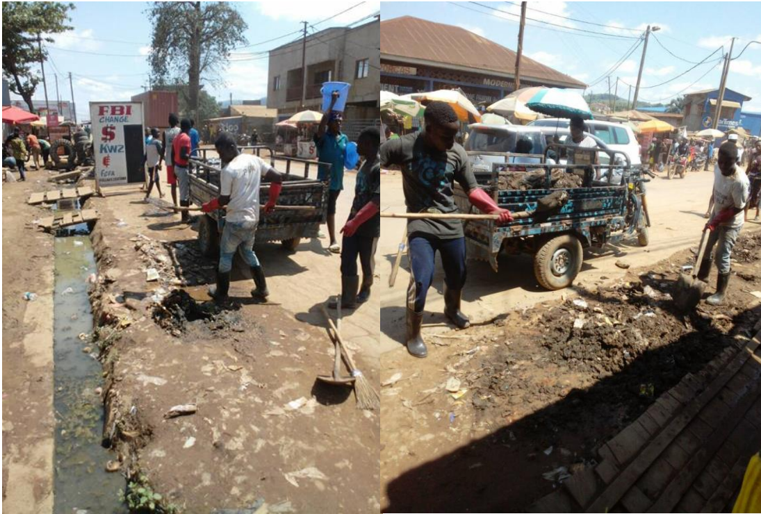
Limpieza y mantenimiento de los canales en diversas calles de Kimpese.
