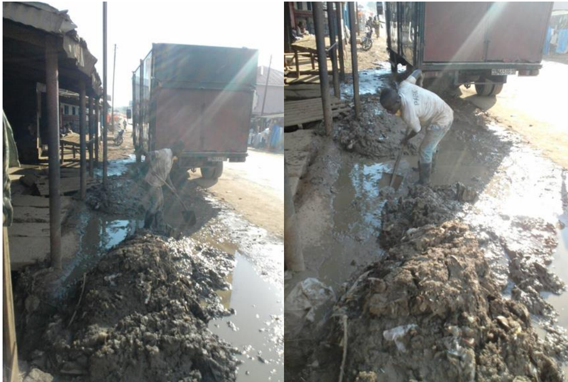
Carretera Nacional 1 a su paso por la zona comercial. Un operario retira la basura y los fangos alojados en el canal de desagüe de los comercios, casas y de aguas pluviales.
