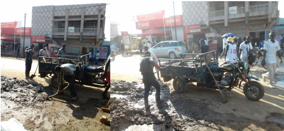
Limpieza y mantenimiento de los canales en diversas calles de Kimpese.
