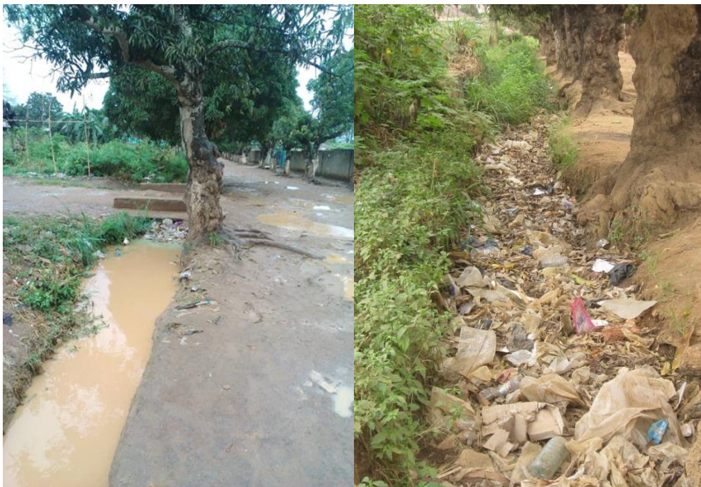
Canal de evacuación de agua pluviales del Mercado de domingo. Fue construido por la administración pública provincial pero no cementado. La foto de la izquierda está tomada en la estación lluviosa mientras que a la derecha es la misma foto en la estación seca.
