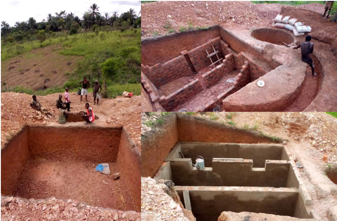
Proceso de construcción de la fosa anaerobia en Kimpese.
