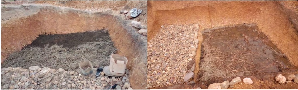
Impermeabilización del fondo.
