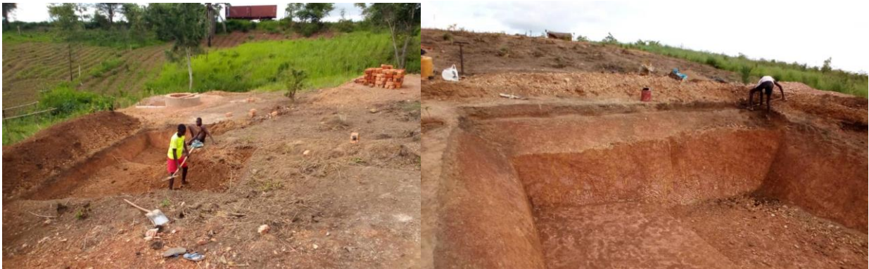
Excavación inicial en Kimpese.
