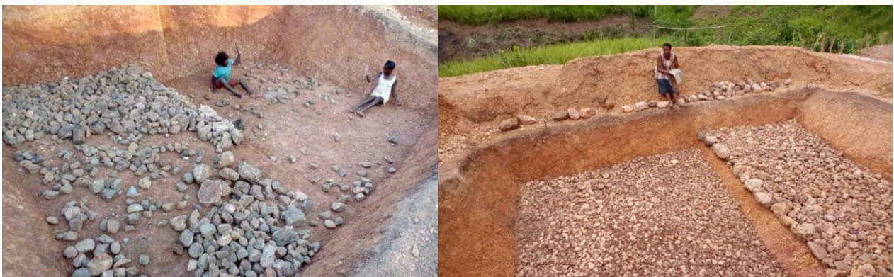
Colocación de la primera capa de piedras.
