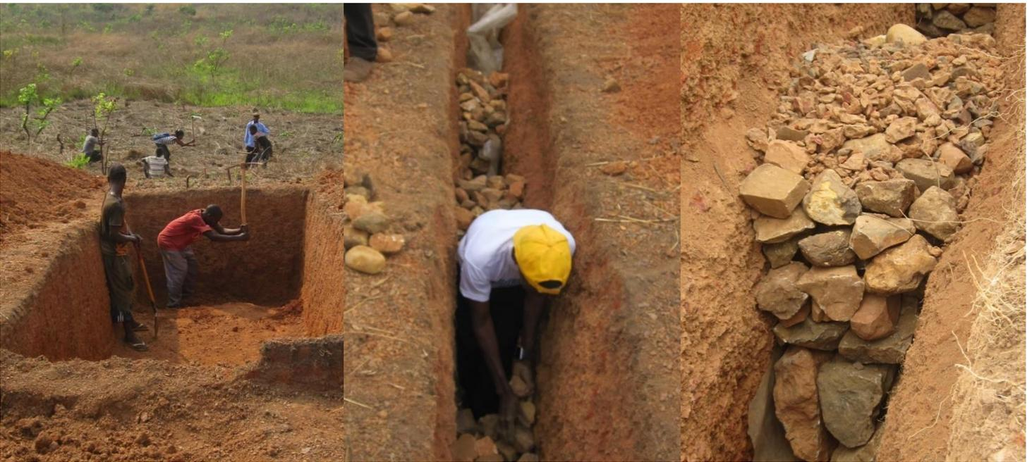
*Excavación del vertedero y preparación del canal de piedras para la salida del lixiviado hasta su posterior saneamiento.*
