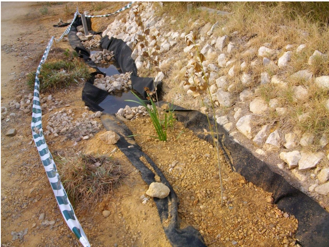
Fig. 9 – Arriba se puede ver el hoyo donde irá uno de los individuos de chopo a estudiar. Abajo el canal ya relleno de piedras, con alguna especie para ver el resultado final y una chimenea colocada al fondo de la foto.
