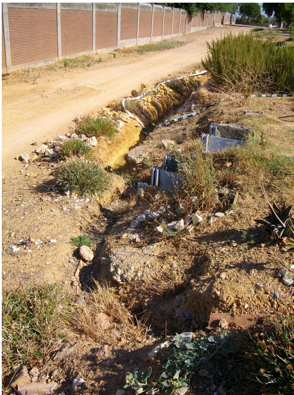
Fig. 4 – Entrada de agua del canal, aprovechando una canalización ya existente visto desde arriba de la bancada.
