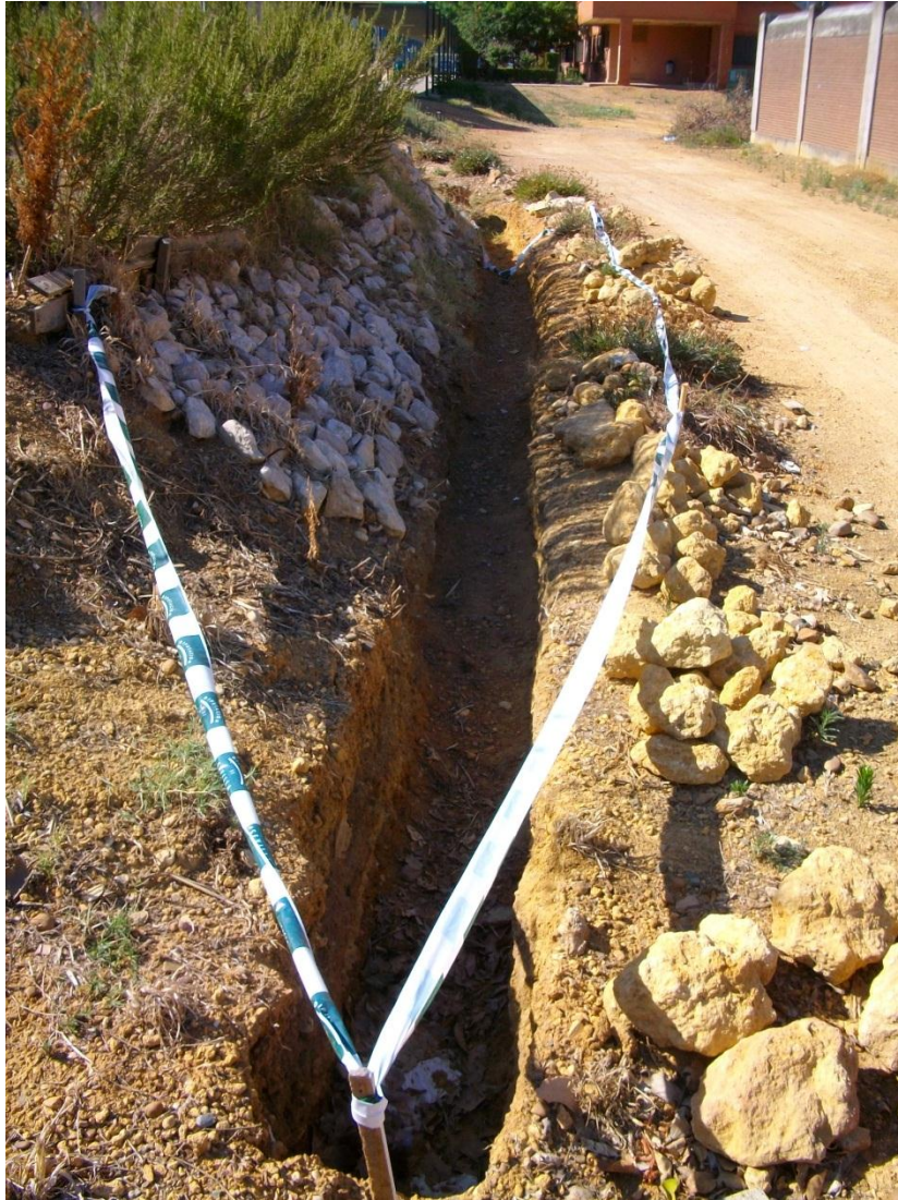
Fig. 3 – Canal excavado visto desde la salida.
