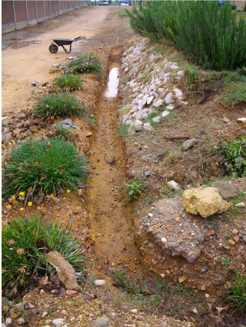
Fig. 2 – Canal excavado visto desde su cabecera.
