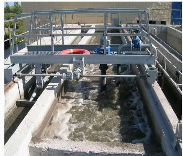
Desarenador-desengrasador aireado con puente móvil
