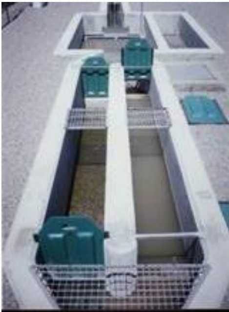
Desarenador estático de canal
