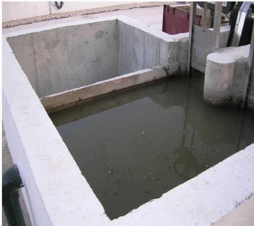
Obra de llegada
