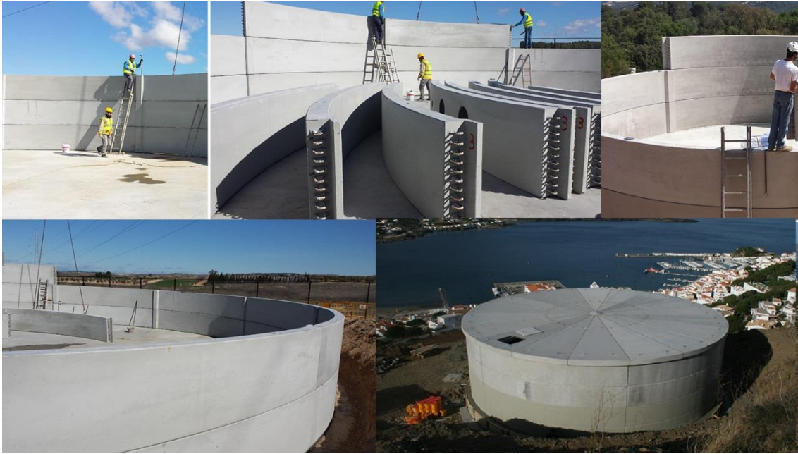
Figura 29. Fase construcción cámara de mezcla
