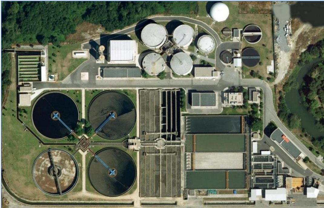
Figura 13. Vista aérea de la planta de Crispijana
