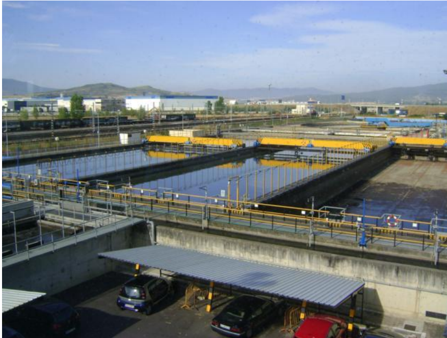
Figura 14. Reactor biológico. Fuente:DAM,2015
