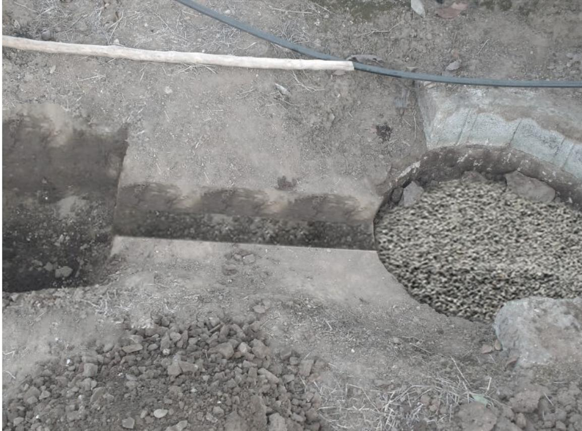
**POZO FINALIZADO: CONSTRUIDO SOBRE LA TIERRA. DESARENADOR Y POZO CON PIEDRA O RIPIO Y GRAVA**
