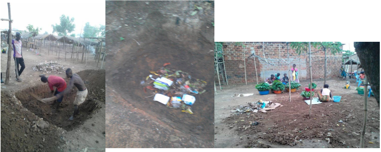
Fotos 14-16: Apertura del hoyo y vertido de los residuos. Naturalización y recuperación del espacio para la venta
