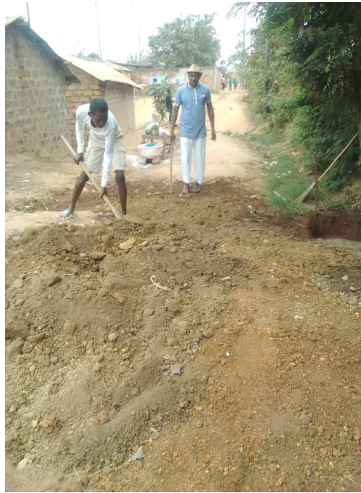
Fotos 114-115: Apertura de canal y colocación de piedras y el tapado del mismo
