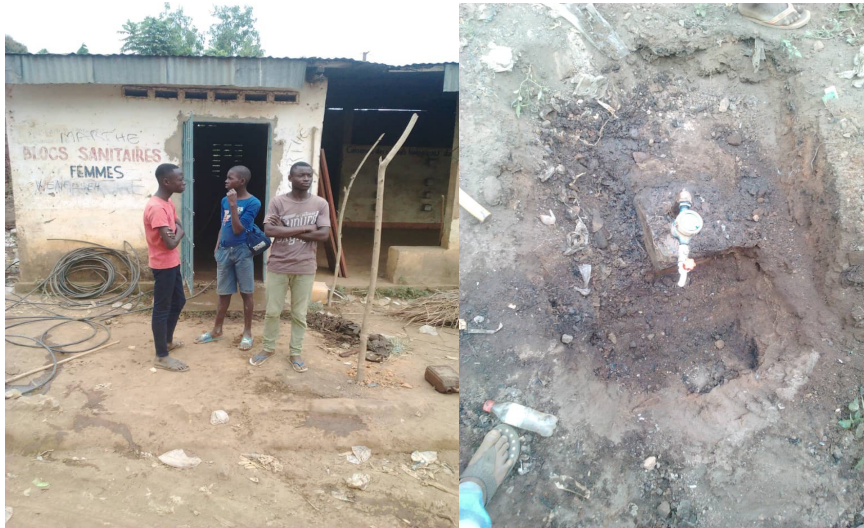
Fotos 50-51: Descubrimiento de la toma de agua en el solar que hay entre los aseos
