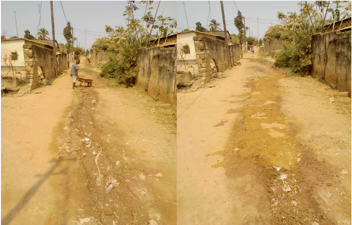
Fotos 116-117: Finalización del canal de piedras
