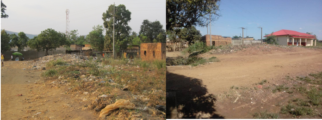
Fotos 8-9: Imágenes comparativas del estado inicial y final desde ángulos opuestos
