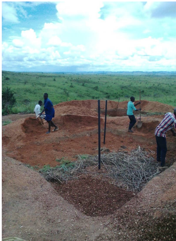
Foto 107: Esparcimiento de la tierra como tercera capa de naturalización
