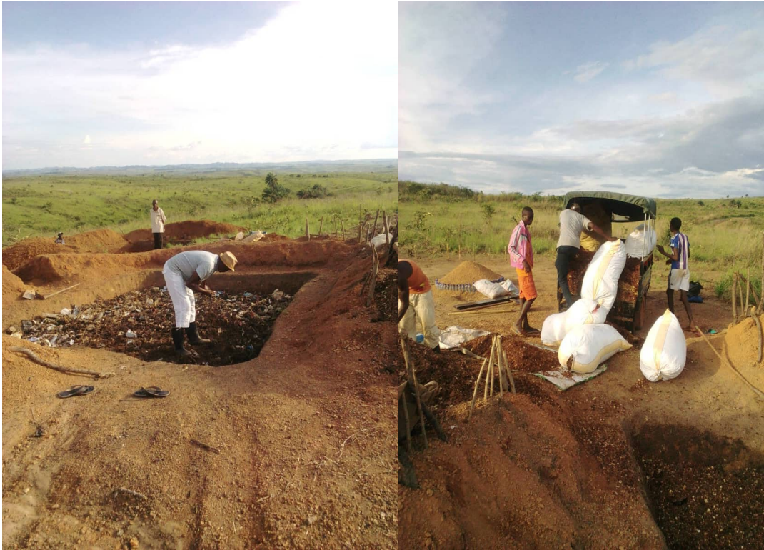
Fotos 102-103: Allanamiento y picado de las basuras. Acopio del serrín
