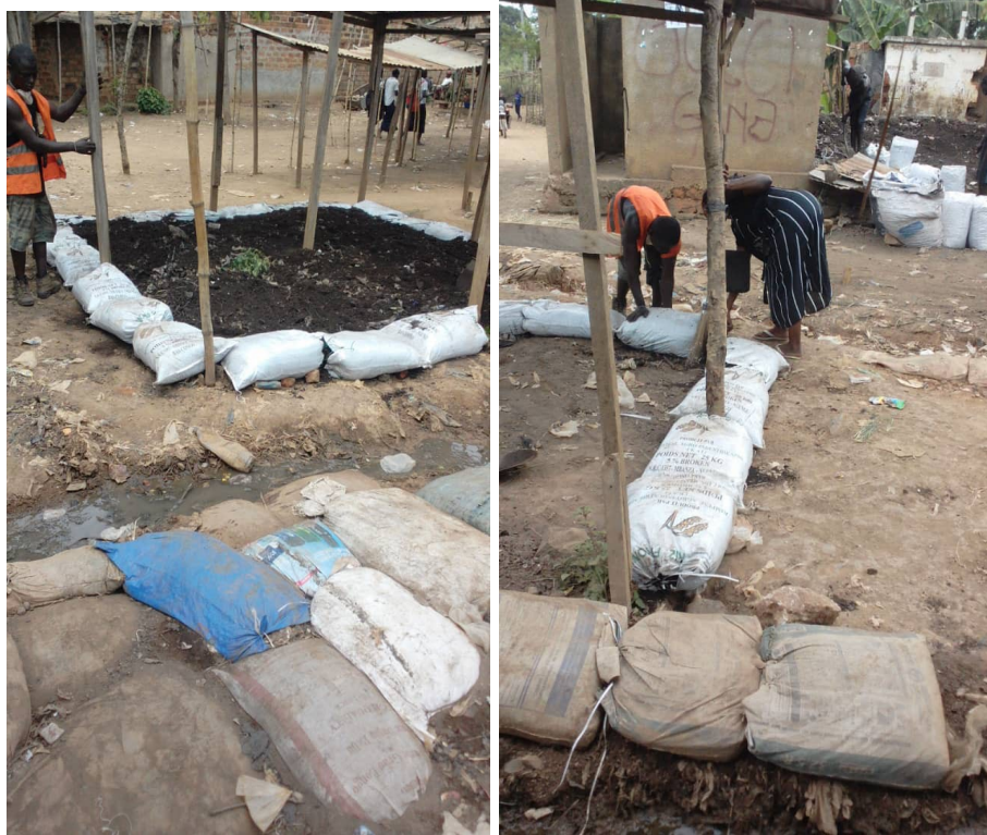
Fotos 74-75: Colocación de los sacos
