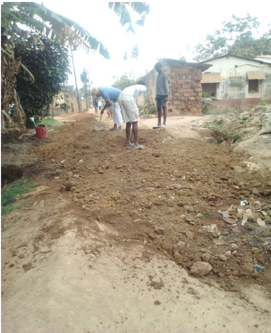
Fotos 114-115: Apertura de canal y colocación de piedras y el tapado del mismo
