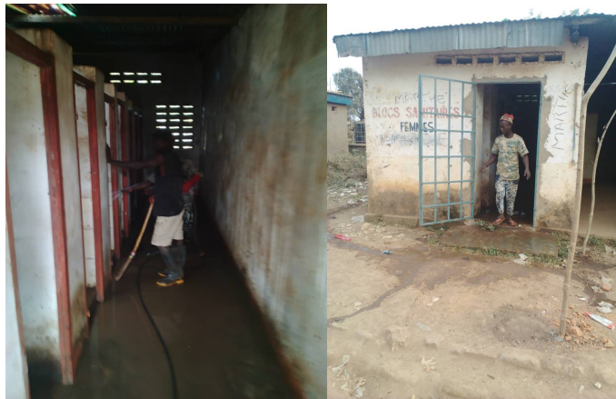
Fotos 48-49: Limpieza de los interiores con agua a presión y productos químicos para desatascar las tuberías ya que éstas presentaban telas y otros elementos.
