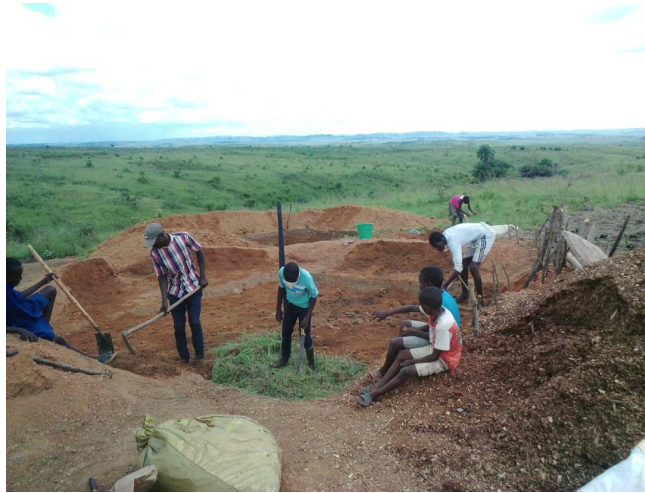
Foto 106: Distribución de la hierba como la segunda capa de naturalización
