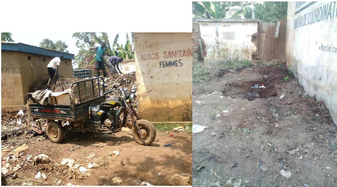
Fotos 59-60: Imágenes comparativas del estado inicial y final del solar
