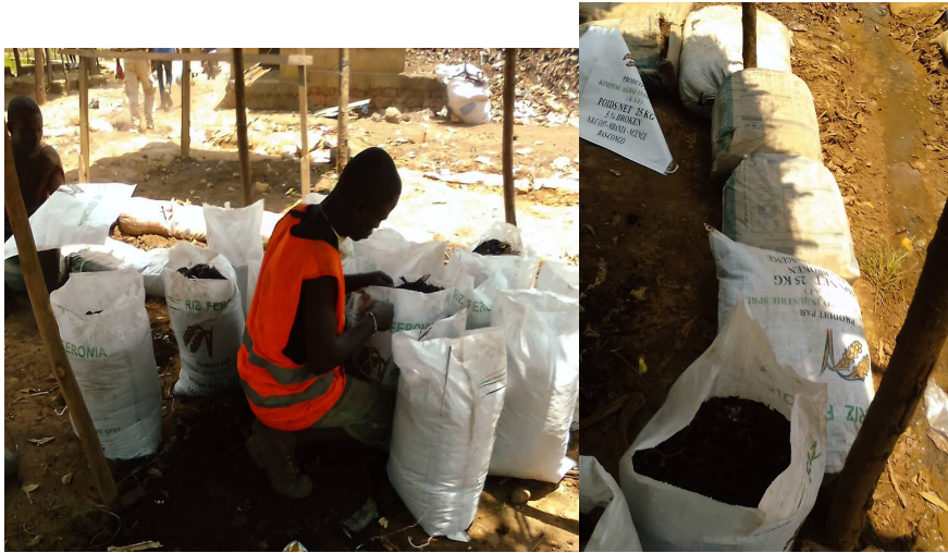
Fotos 72-73: Preparación de los sacos
