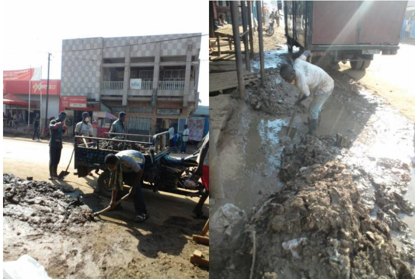
Fotos 12-13: Limpieza de las cunetas en la Nacional 1 a su paso por Kimpese
