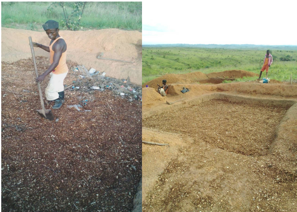
Fotos 104-105: Distribución del serrín, primera capa de naturalización
