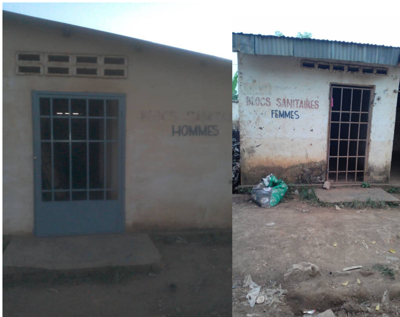
Fotos 46-47: Fachadas de los aseos
