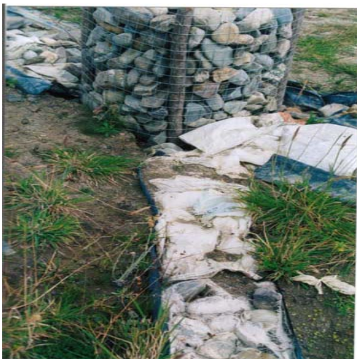
Figura 9 Canal de drenaje
