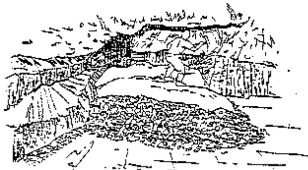
Figura 26 Extracción de la tierra para cubrir la basura
