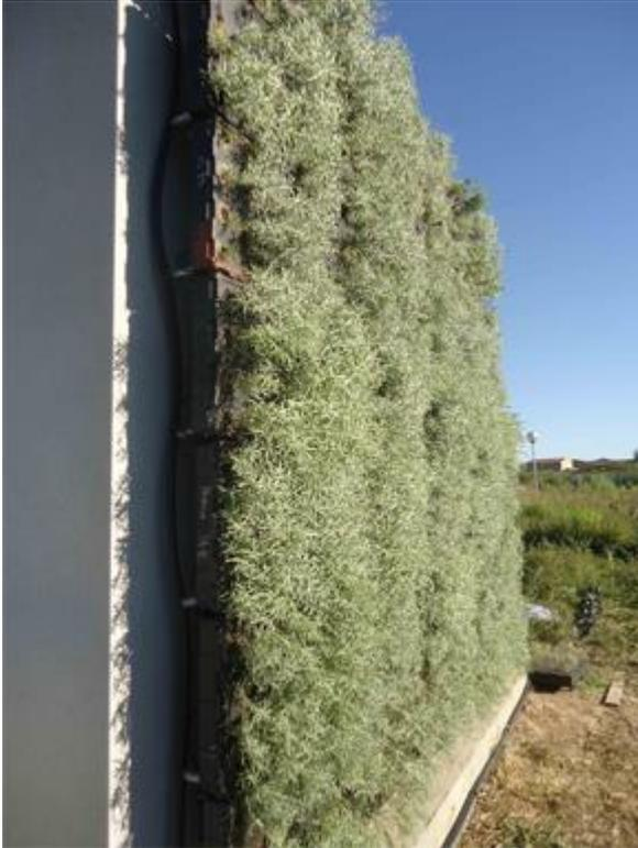
La estructura que presentan estos muros es: un esqueleto que orienta la valla y permite la sostención, y unos módulos que mediante su disposición crean una capa que permite la insonorización.
